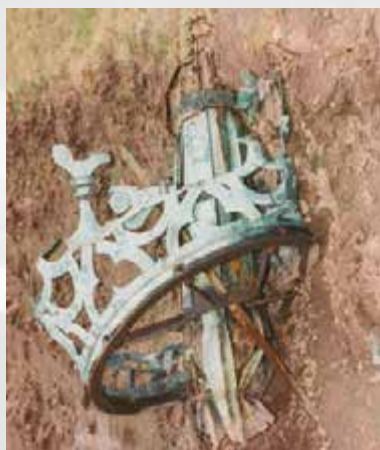
W 1997 roku w Wielki Piątek wichura zerwała z prawej wieży koronę i krzyż. Korona upadła na ziemię, krzyż wbił się w dach wieży
