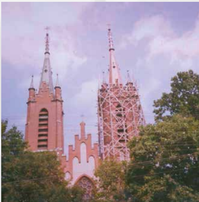
Remont wież trwał od 1997 do 01.06.2000 roku. Koszt remontu wyniósł 160 000 000 zł
