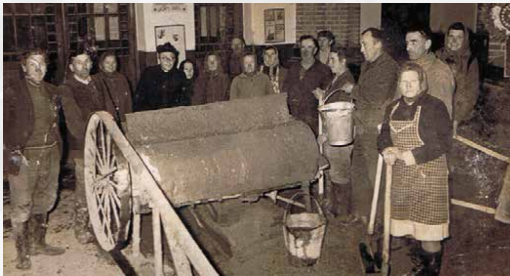
Prace remontowe 1973-1975 wewnątrz kościoła – zalewanie pęknięć w stropie
